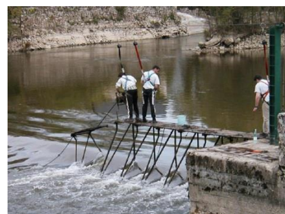
Remontée d'un tablier au barrage de Nitray (crédit : Syndicat du Cher canalisé)
