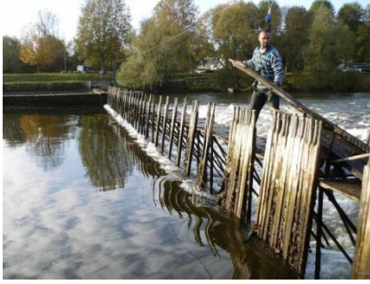
Manœuvre des aiguilles au barrage de Bléré. (crédit : Syndicat du Cher canalisé)
