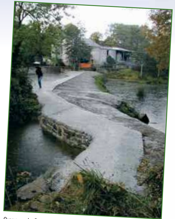
Ouvrage de Guidreau, Aigrefeuille-sur-Maine
