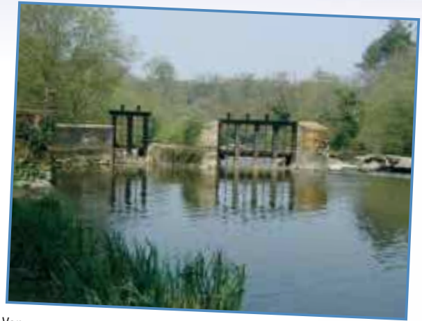
Vannage restauré et fonctionnel
