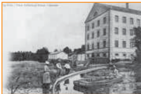
La carte postale ancienne témoigne du besoin d'eau pour les usiniers, confrontés à la récurrence d'étiages prononcés (rehausse sur l'ouvrage). En aval, de la chaussée de Gaumier, le développement de la végétation et la présence du gué charretier signalent un niveau plus bas que celui maintenu actuellement (photo de droite).
