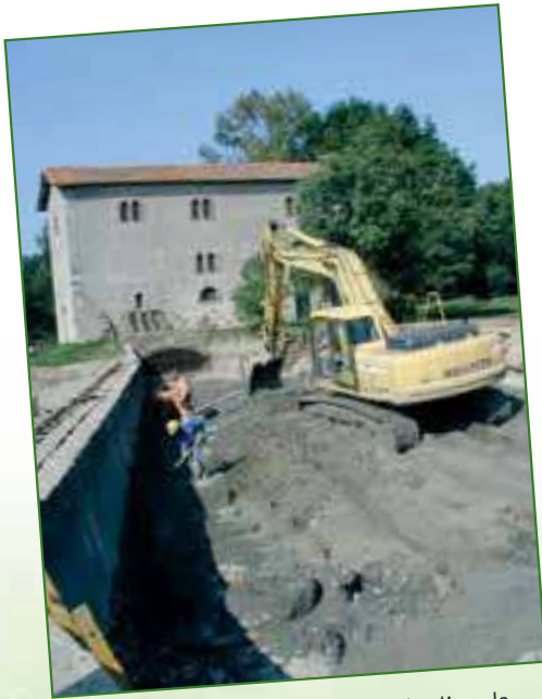
La restauration de certains ouvrages implique la mise en œuvre de chantiers importants. Ici la restauration de la chaussée du moulin du Gué à la Pommeraiie-sur-Sèvre en 2002.
