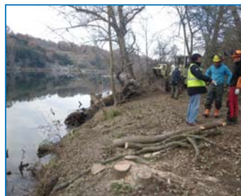
Chantier-école avec le CFPF : restauration de zones d'expansion de crues - secteur de Vallon Pont d'Arc (photo du 11 décembre 2013)
