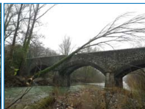
Pont sur l'Auzon à Saint Germain : intervention en urgence le 16 janvier 2014
