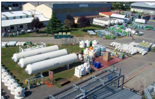
Site SEVESO à Saint-Priest
