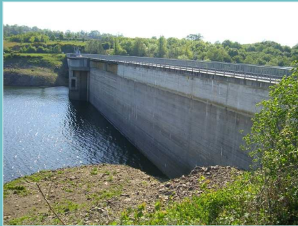
Usine d'eau potable du SERTAD
