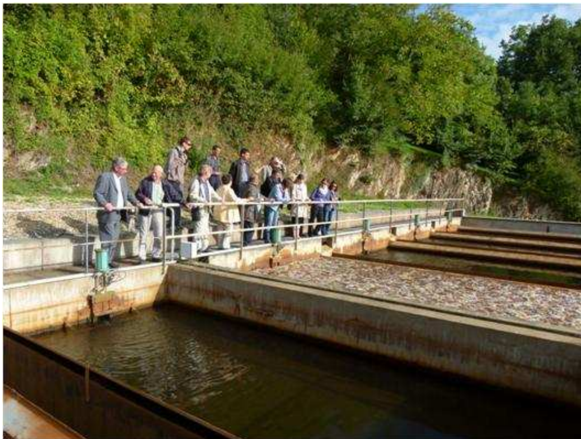
Usine de la Corbelière : bassins de filtration sur sable
