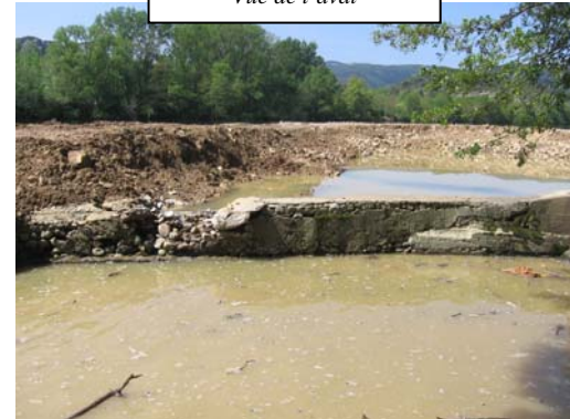
Vue de l'aval
