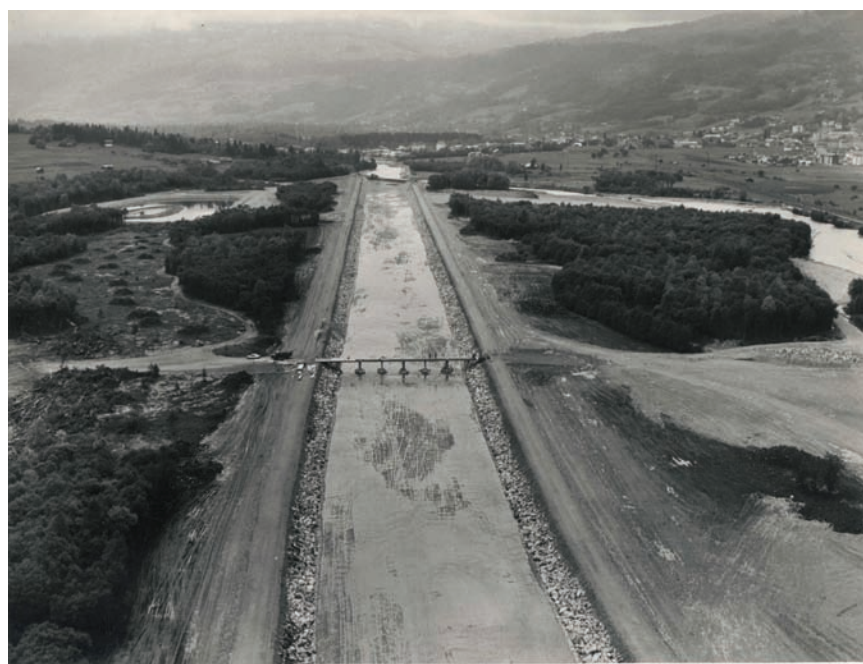
Photo 22 : À l'image de l'Arve à Sallanches, de nombreux cours d'eau du bassin versant ont fait l'objet d'endiguements destinés à protéger les espaces riverains et à étendre les terrains exploitables sur les anciennes zones de divagation et de tressage (Source : Cantoni). Ces aménagements ont eu pour conséquence de provoquer un auto-curage du chenal engendrant des incisions généralisées. Il en est également résulté une perte en biodiversité suite à la déconnexion des espaces riverains de la rivière, autrefois régulièrement renouvelés, et à la perte d'habitats pour la faune aquatique et terrestre.
