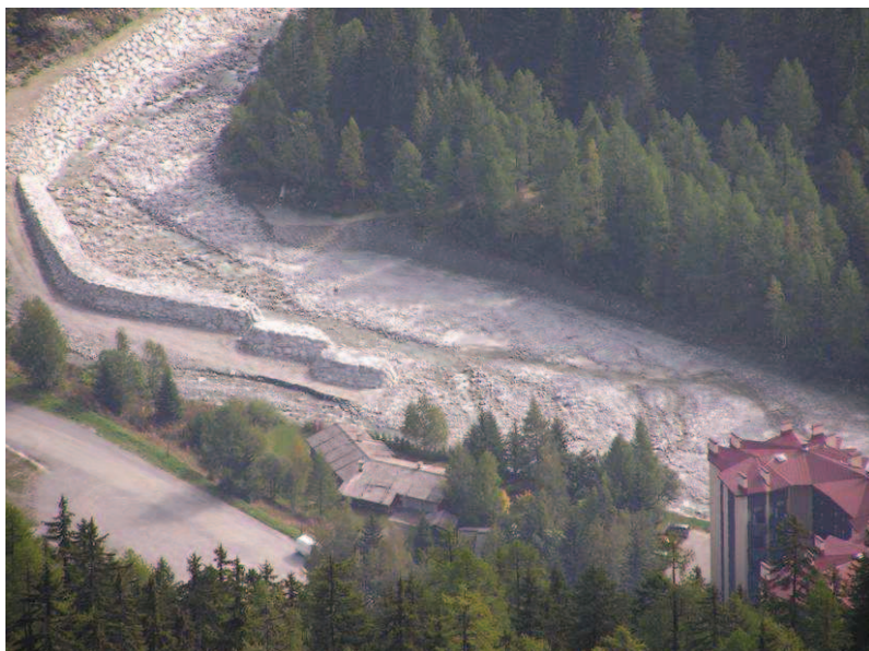
Photo 6 : Plage de dépôt de l'Arveyron d'Argentières à Chamonix(source : SM3A). Les plages de dépôt ont pour principe de provoquer le dépôt des matériaux charriés par les torrents à l'occasion des crues en modifiant la géométrie du chenal : réduction de la pente et élargissement. Dans l'exemple ci-dessus, l'Arveyron est en outre dévié afin de ne pas bloquer les écoulements de l'Arve et provoquer des débordements.
