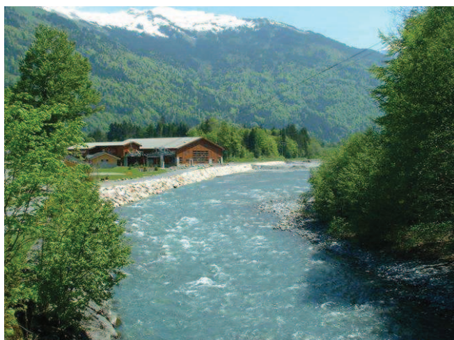
Photos 7 et 8 : Protections de berges dans la traversée du Grand-Bornand (Borne) et au droit de la commune de Samoëns (Giffre) (source : SM3A). La plupart des berges des cours d'eau du bassin versant ont aujourd'hui fait l'objet de travaux d'endiguement.
