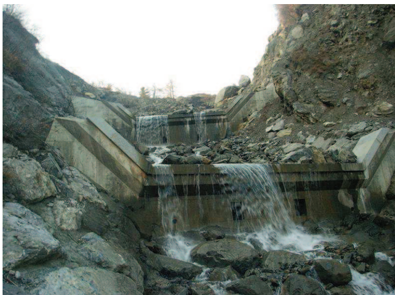
Photo 5 : Seuils sur le Nant Bordon à Passy (source : SM3A). Ces seuils, qui concernent une grande partie des torrents du bassin versant de l'Arve, ont pour vocation de stabiliser le profil en long des torrents et de dissiper l'énergie des crues et autres laves torrentielles par des chutes successives.
