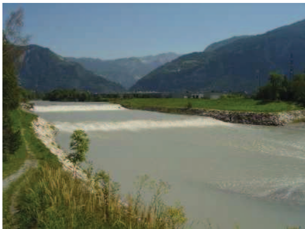
Photo 9 : Seuil et contre-seuil de Pressy sur l'Arve (communes de Thyez et Scionzier) (source : SM3A). Le contre-seuil a été réalisé dans le cadre du contrat de rivière Arve pour stopper la déstabilisation du seuil principal menacé par l'incision de la rivière
