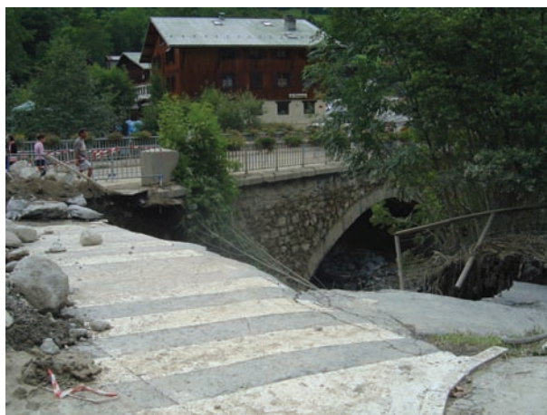
Photo 34 et 35 : Dommages causés par la lave torrentielle du Nant d'Armancette en août 2005 aux Contamines-Montjoie (source : SM3A).
