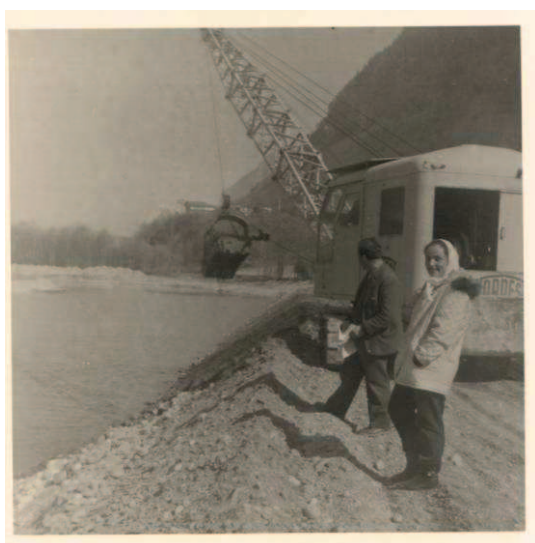
Photo 10 : Travaux de curage à Sallanches dans les années 1960 (source : Cantoni). Les opérations de curage ont concerné tous les cours d'eau du périmètre d'étude, et plus généralement des Alpes. Elles ont entraîné des phénomènes d'incision sur la plupart des rivières dont les effets se font sentir plus de 20 ans après leur arrêt.
