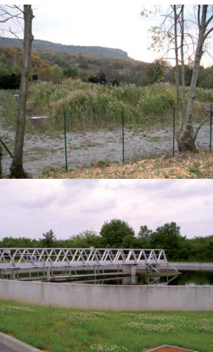
Exemple de station d'épuration (filtre planté de roseaux / boues activées)
