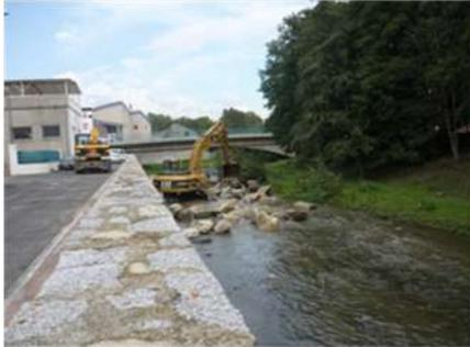
*Création d'une riseberme afin de réduire la largeur du cours d'eau et ainsi d'augmenter la hauteur de la lame d'eau*
