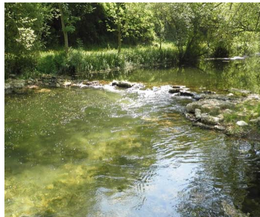
Clapet de l'abattoir sur la Dive avant abaissement. Le clapet a été abaissé pour assurer la continuité écologique et des micro-seuils en aval ont été mis en place pour maintenir la ligne d'eau (Photos : Syndicat du Clain Sud)
