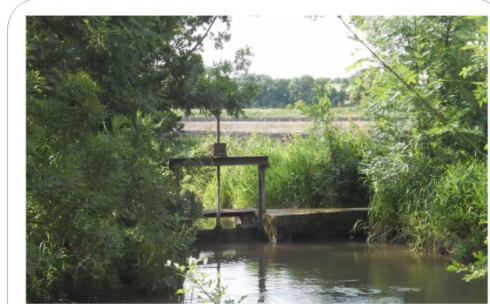
Ouvrage n° 31: Vanne Caractéristiques de l'ouvrage : Longueur : 1 m Largeur : 5 m Hauteur : 1,8 m Gestion : publique
