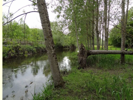
Elargissement du lit de la Boivre du à la mauvaise tenue de la berge par le système racinaire superficiel du peuplier
