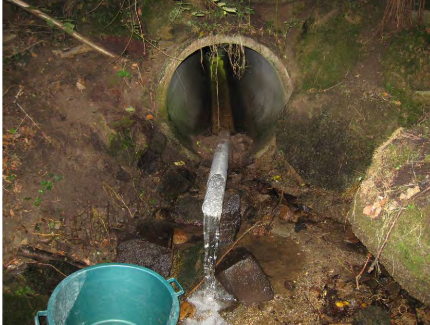
Figure 31 : Mesure de débit sur le ruisseau de la pépinière
