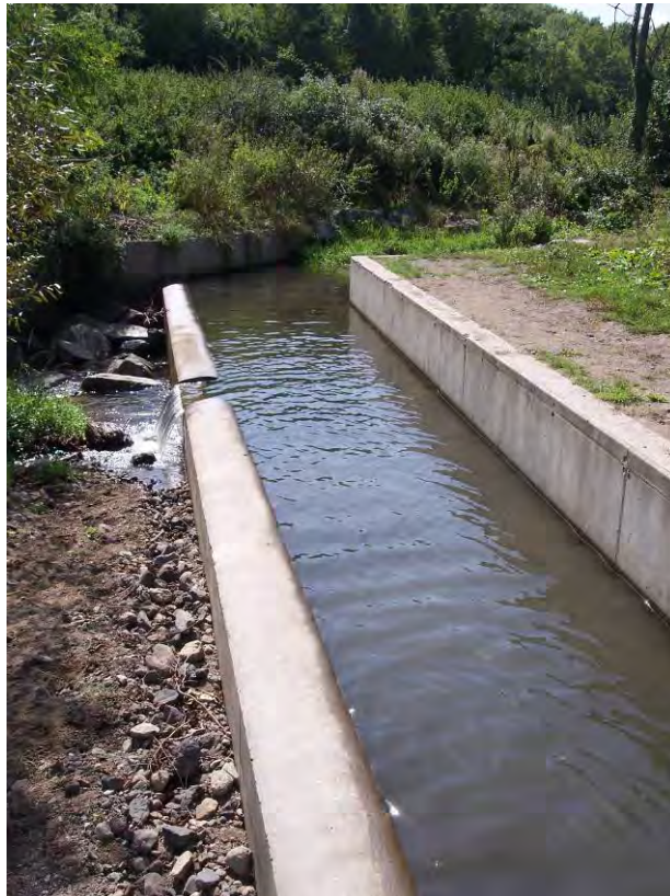
Figure 34 : Mesure de débit sur le ruisseau de Saussade
