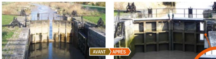
**Localisation :** sur le canal Charente - Seudre / bassin de l'Arnoult. Porte à flot soumise à marée couplée avec une vanne double vantelle en amont.
