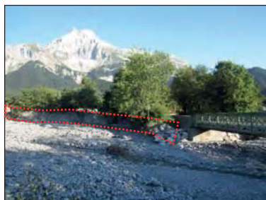
Merlon de protection fortement dégradé en rive gauche - dépôts accumulés en lit (pont du Serre, le 03/09/2013)
