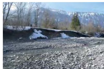
Digue de protection du hameau de Donnière sur la Donnière avant intervention
