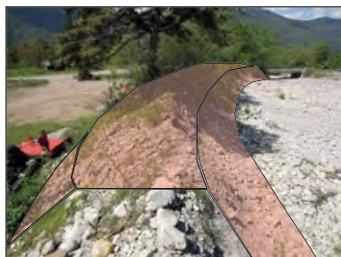
Merlon en rive gauche du pont du Serre fortement érodé (vue vers aval) : aménagement d'une digue
