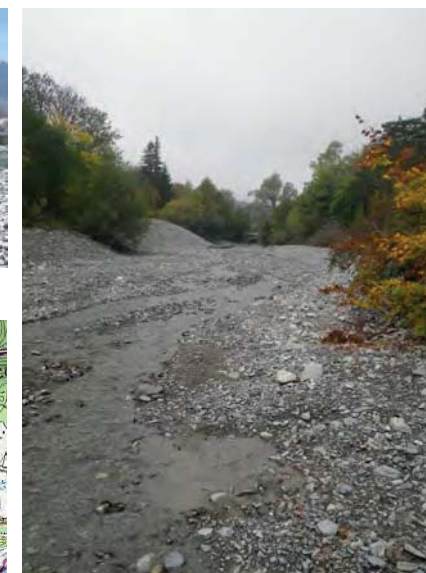
Digue après intervention
