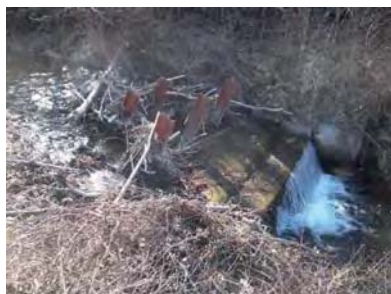
Piège à flottant situé en amont du barrage de la plage de dépôt
