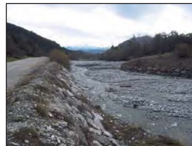
Confluence Donnière - Fraches (vue vers aval) : piste en rive gauche, barrage de stabilisation en fond
