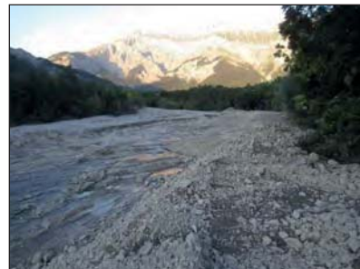
Ebron - confluence Rapidet (vers amont), le 13/09/2013 : Travaux de curage d'urgence suite à la crue du 8/07/2013
