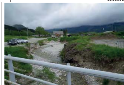
Site 1 : Vue d'ensemble du secteur au droit de l'ancienne retenue collinaire
