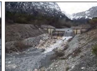
Barrage de stabilisation (n°125) en aval des Fraches
