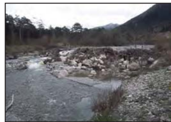
Barrage des Orgines sur l'Ebron – infranchissable et d'état moyen (ancrage d'encrochements démantelé)
