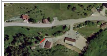
— Erosion de berge en rive droite
