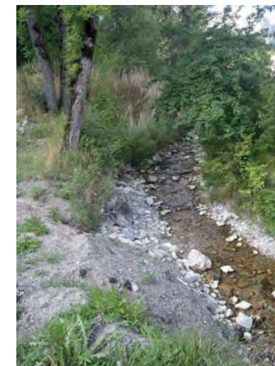
Site 2 : Erosion de berges en rive droite de la Gresse
