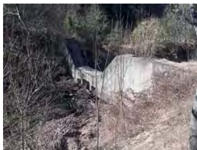
Barrage de la plage de dépôt obstrué d'encombres
