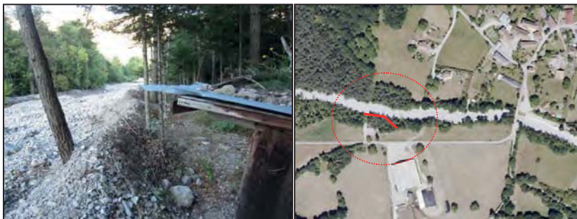
Rapidet en aval du pont du Serre (3/09/2013) - vue vers l'amont en limite de la propriété : merlon de protection effacé après crue du 8/07/2013
