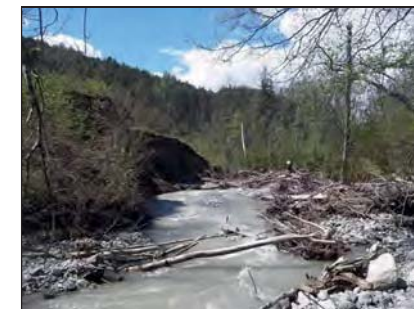
Encombres en lit sur la Vanne en amont de Chardayre (berges déstabilisées sur le secteur)
