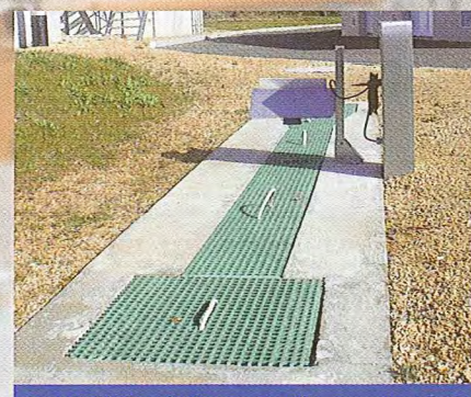
Canal débitmétrique et préleveur de sortie
