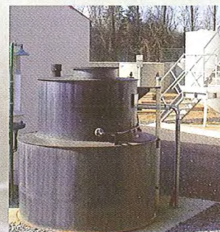
Cuve de chlorure ferrique
