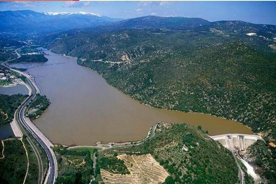
Barrage de Vinça sur la Têt - 1987
