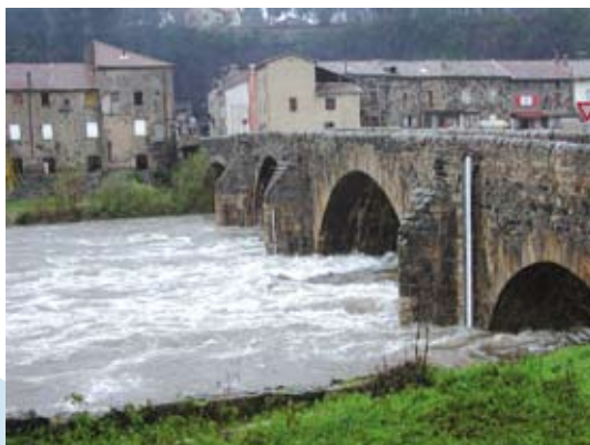
Pont de Labeaume - limnimètre crue de décembre 2003
