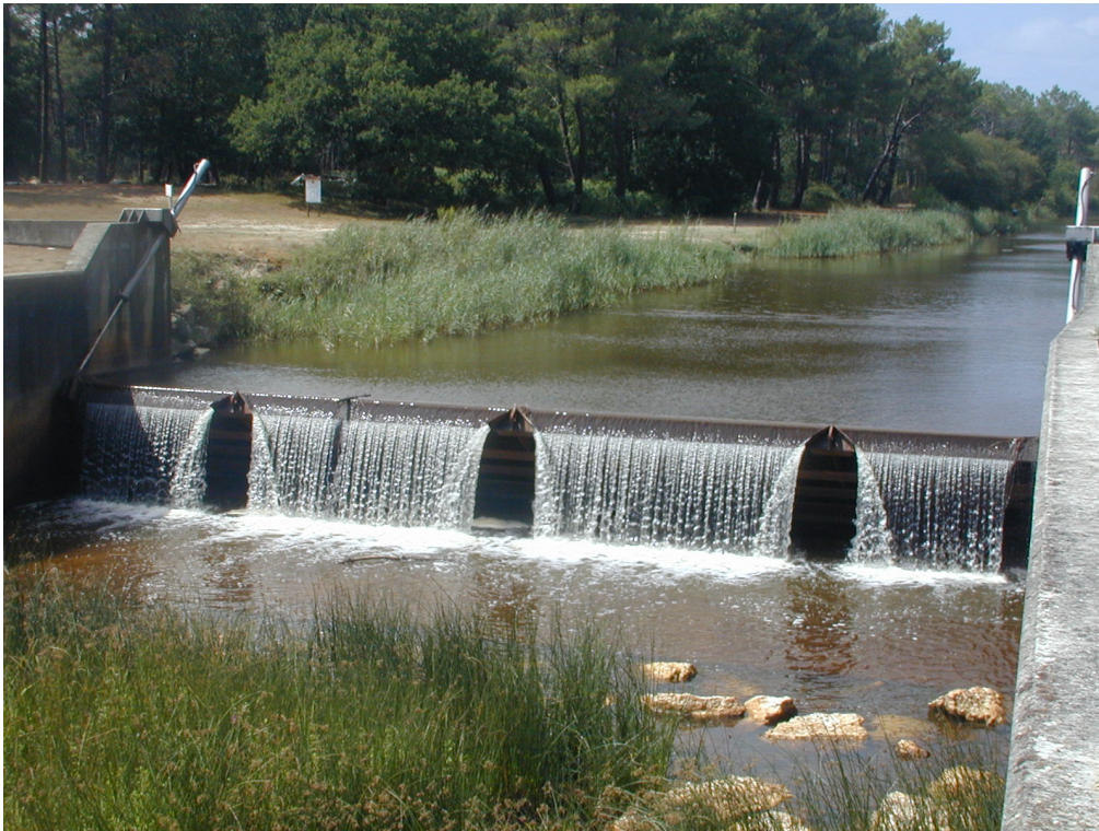
Ecluse du Pas du Bouc sur le canal des Etangs, Le Porge
