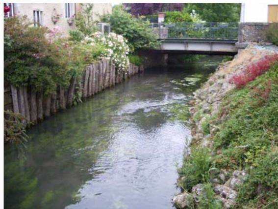
Photo 6 : Palplanches et enrochement limitant les fonctions écologiques des berges.
