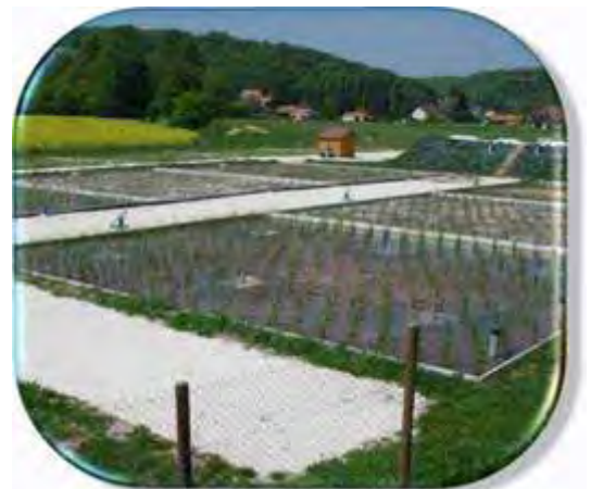
Fig. 18 : Station d'épuration sur lits filtrants à macrophytes (roseaux)
