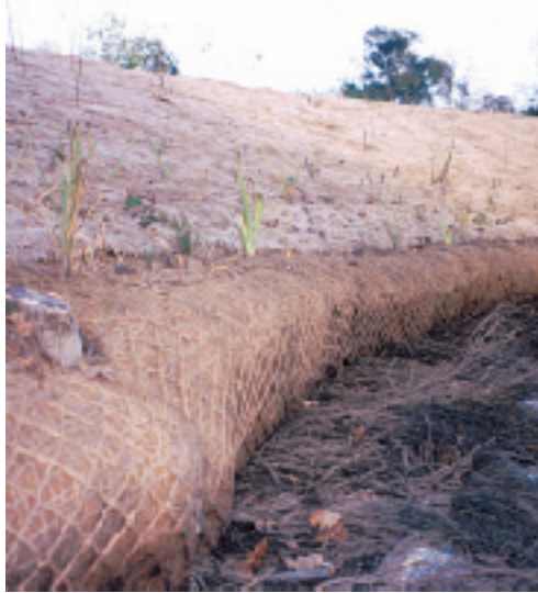
Fascine d'hélophytes : Au lieu dit de Taillepré à Martigné-Briand, vue de détail
