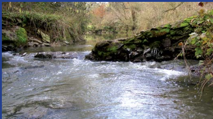
Chaussée s'effaçant naturellement, améliorant la continuité écologique
