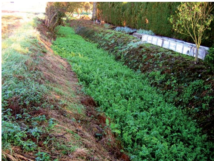
Photo n°2 : l'Aubance avant travaux
