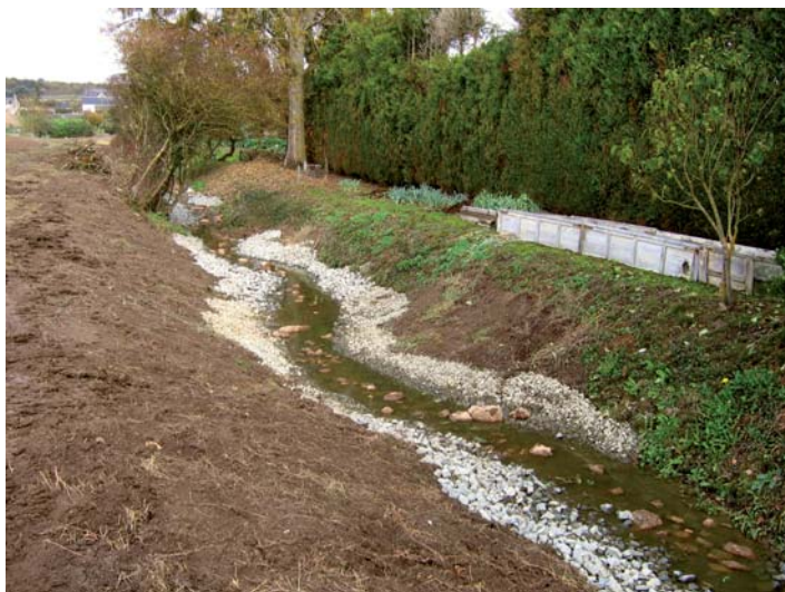
Photo n°3 : l'Aubance après travaux
