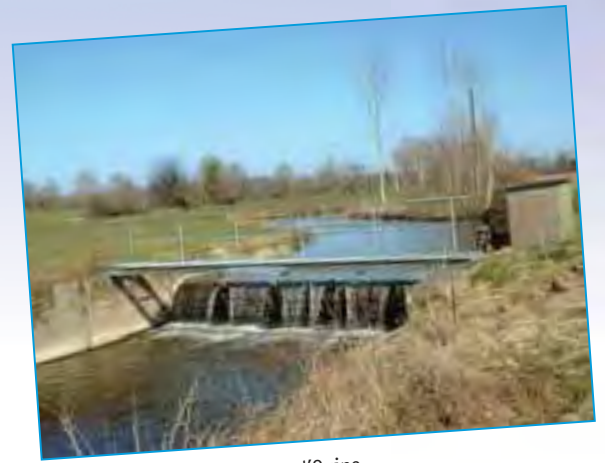
Clapet du pont de l'écluse sur l'Ouine, communes de Largeasse et du Breuil Bernard
