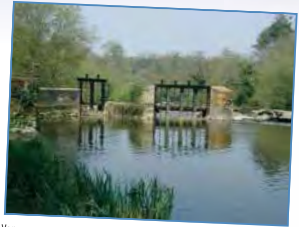
Vannage restauré et fonctionnel
