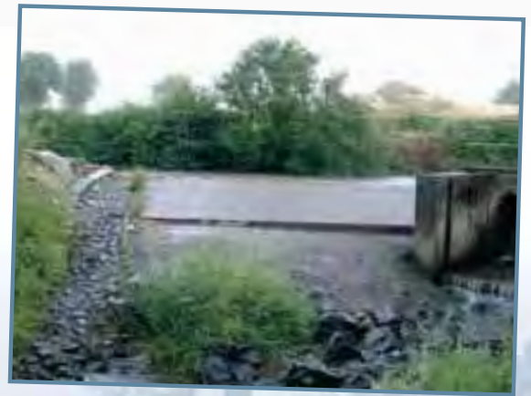
L'anguille est le poisson migrateur emblématique du bassin versant. L'amélioration de son parcours migratoire ne passe pas nécessairement par la réalisation d'aménagement lourd. Ici, l'aménagement rustique du parement du déversoir du moulin de Jourdain sur la Sèvre amont (source CSP).
