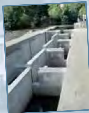
L'anguille est le poisson migrateur emblématique du bassin versant. L'amélioration de son parcours migratoire ne passe pas nécessairement par la réalisation d'aménagement lourd. Ici, l'aménagement rustique du parement du déversoir du moulin de Jourdain sur la Sèvre amont (source CSP).
