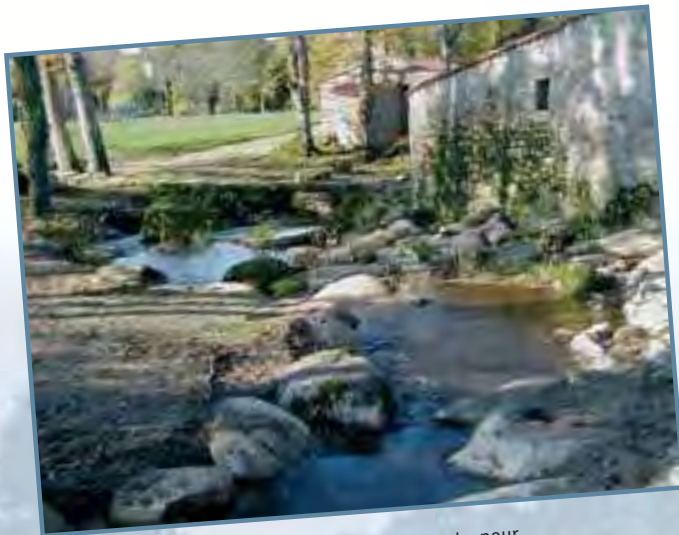
Aménagement d'un bras de contournement pour faciliter le passage de l'anguille sur la chaussée de Gaumier, Cugand
