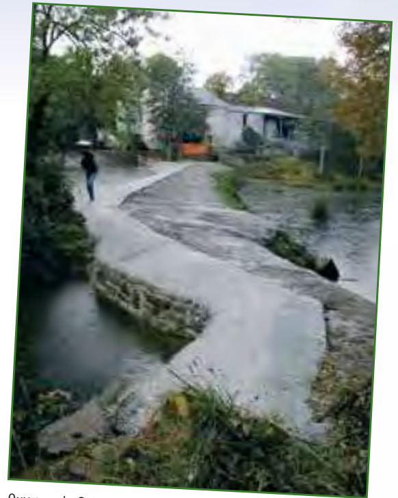
Ouvrage de Guidreau, Aigrefeuille-sur-Maine
