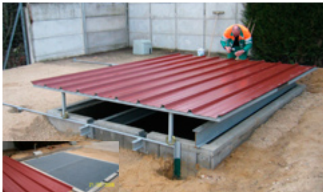
Finitions de l'aire de lavage
