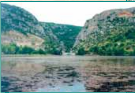
La gestion des proliférations végétales dans les retenues (Source : Société du Canal de Provence)
