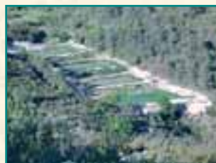
La réalisation de stations d'épuration (Source : Mairie de Comps-sur-Artuby)
