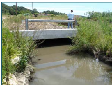
Ouvrage hydraulique (OH4) sur le Béal
