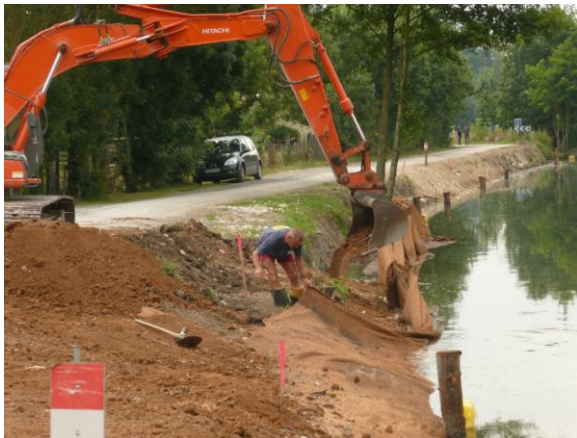
Réalisation des travaux
