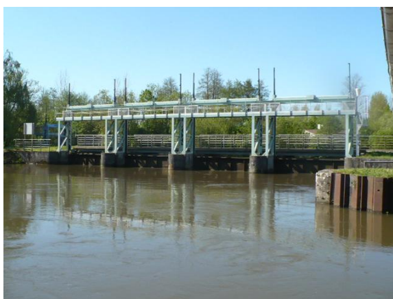
Barrage à vannes-vantelles de la Sotterie (DPF)
