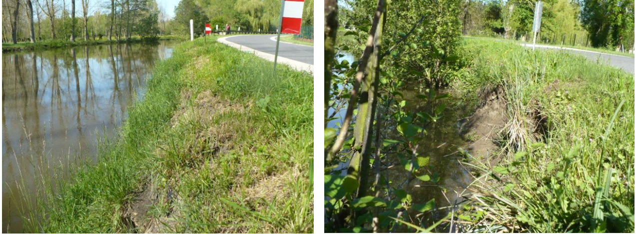
Erosion et glissements de berge en bordure de la voie départementale
