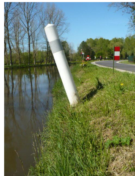
Zone de danger / projet de glissière de sécurité nécessitant une restauration préalable de la berge
