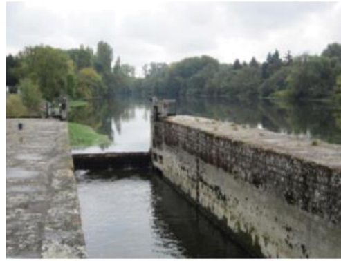
Ecluse en rive droite
