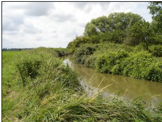
Figure 7: Le Lane rectifié et recalibré, perte de l'équilibre morphodynamique
