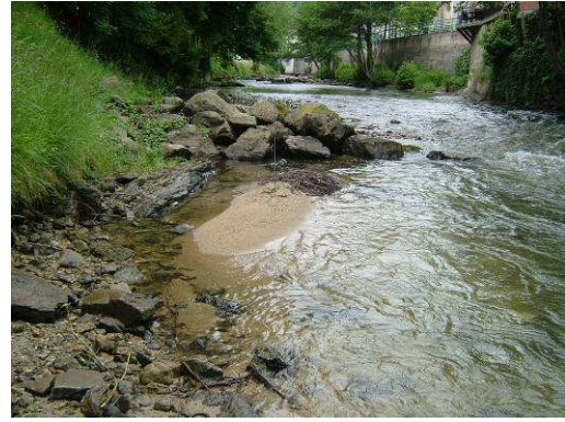
Figure 16 : Aude à Axat ; banc de sable accumulé à l'abris d'un épis en enrochements (seg.31_a)
