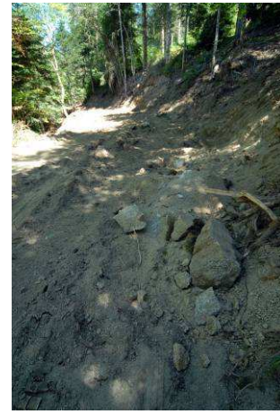
Figure 37 : Piste forestière à proximité de la Clarianelle déstructurée par le passage des engins de débardage (source B. Le Roux)
