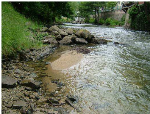
Figure 59 : Dépôt récent de sable à l'aval d'un épis (Aude à Axat)
