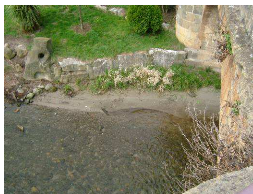
Figure 61 : Dépôt de sable sous le pont de Campagne-sur-Aude
