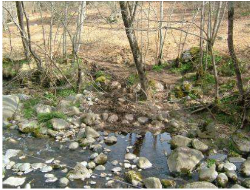
Figure 45 : Berge déstabilisée sur la Bruyante
