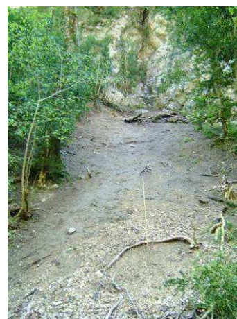
Figure 35 : Glissement de terrain (Aude, Amont de Nentilla)
