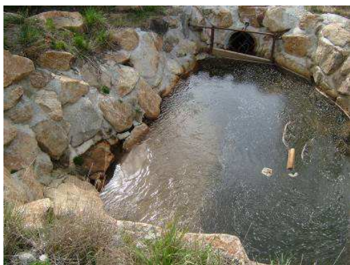
Figure 43 : Bac de dessablage (Pla del Mir, station les Angles)
