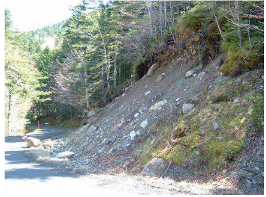
Figure 39 : Talus instable en bordure de RD 84
