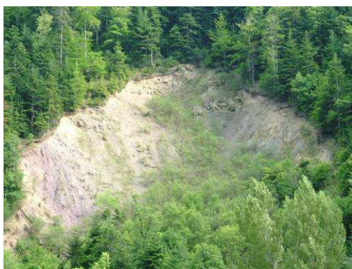
Figure 34 : Eboulement à Gesse (1992) en cours de stabilisation
