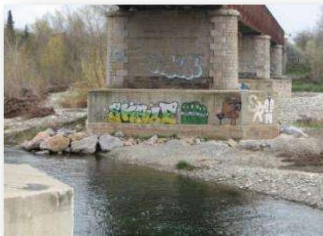
Figure 7 : Pont de Brouilla : déficits en sédiments entraînant un déchaussement de la pile du pont
