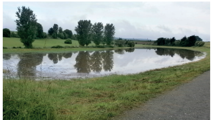
Digue de l'Orme du ramoneur de Moisselles
