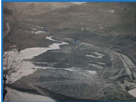
Avant la construction
