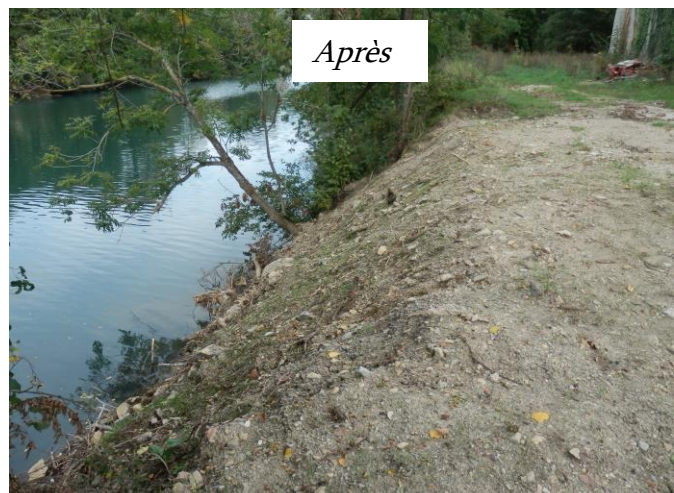
Enlèvement d'une cépée d'arbre tombée et reprofilage de la berge à Millau
