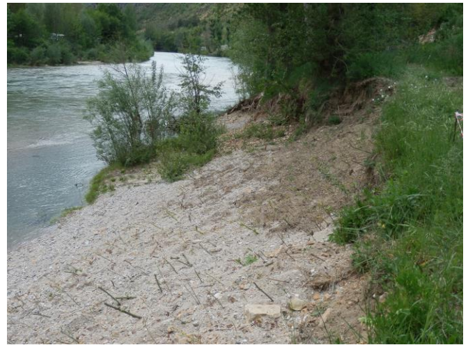
Reprofilage et bouturage de la berge à Mostuéjols
