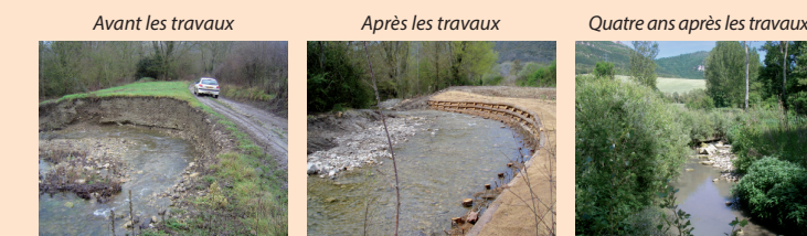
Avant les travaux
