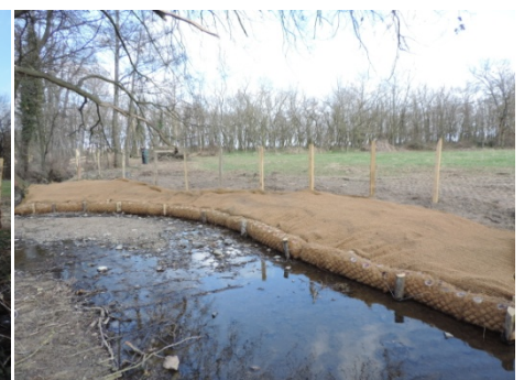
Préparation d'un boudin végétalisé
