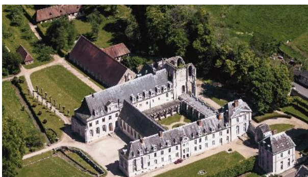
Photographie 37 : Abbaye Notre Dame de Fontenelle à Saint Wandrille – source Saint Wandrille.com
