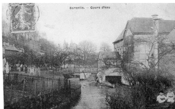
Photographie 17 : Ancien moulin de l'Austreberthe à Barentin.
