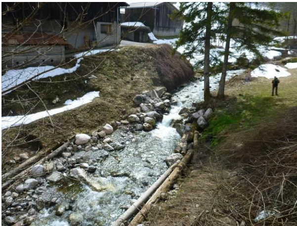
Protections de berges en fuste de bois à Montremont
