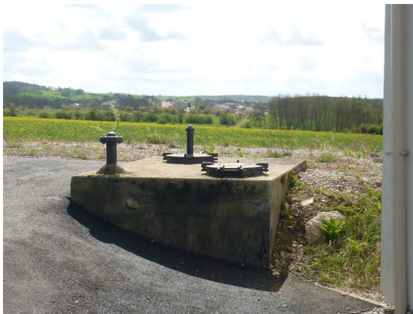
Figure 33 : Forage aux GTI sous couverture de Villers - Syndicat d'eau potable de la Région Mirecurtienne (Source : Conseil Général des Vosges - Avril 2012)
