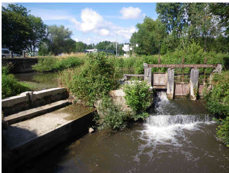
Vannage de décharge du moulin Neuf
