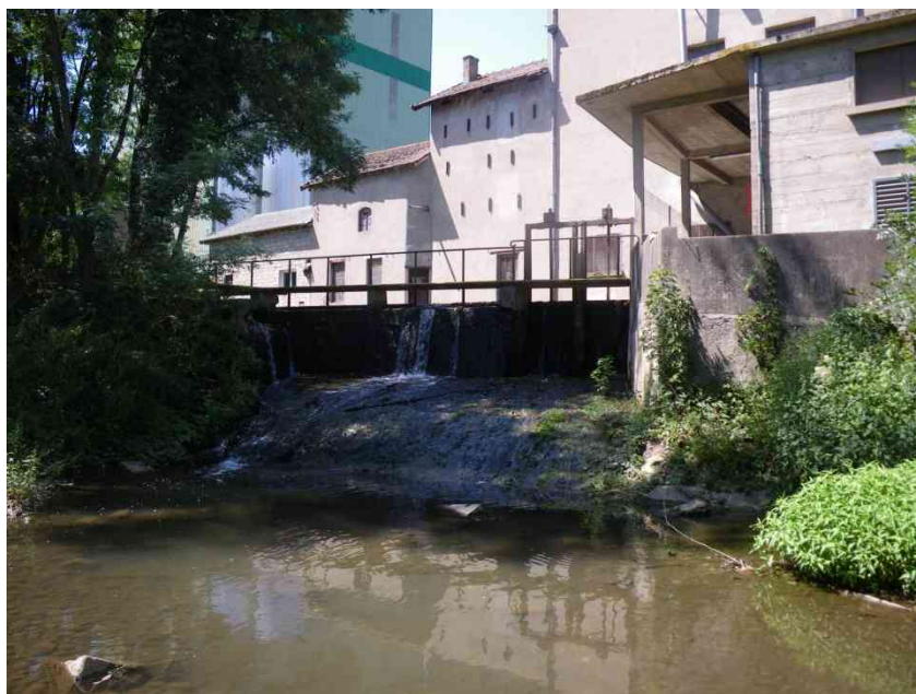
Vanne de décharge du moulin Champagne
