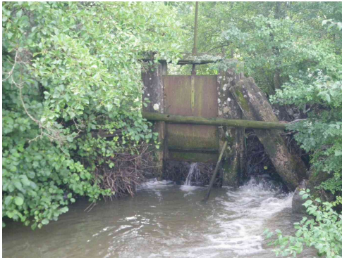
Seuil en amont du moulin de Longchamp
