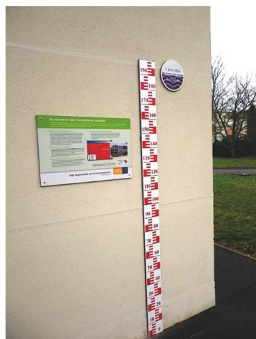
Echelle limnimétrique et repère de crue
