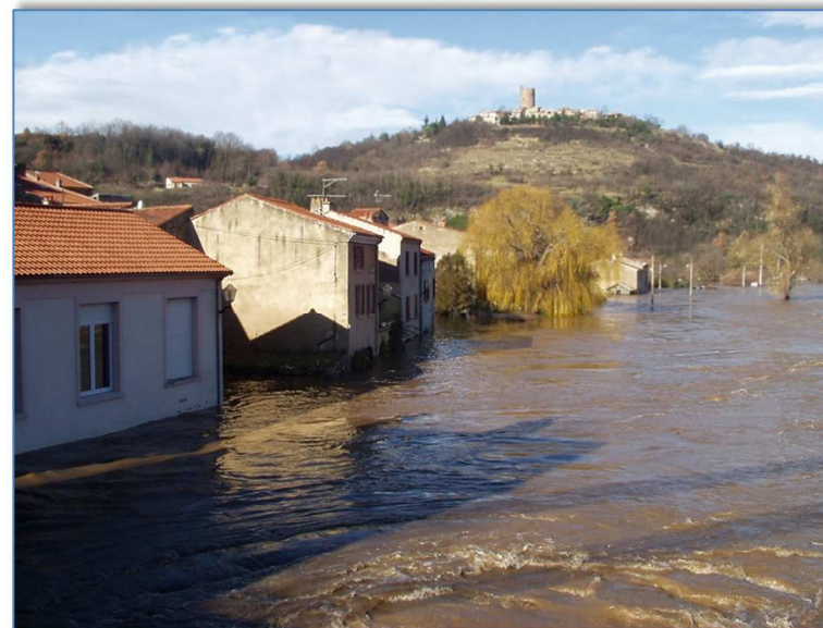
Crue de l'Allier à Coudes (63)
