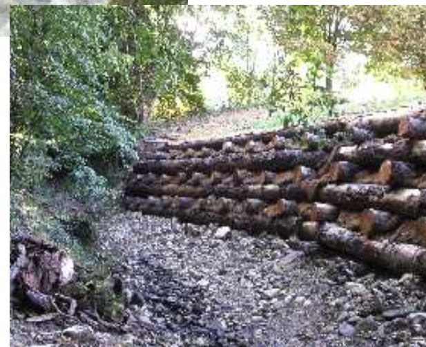
Le Groise après travaux
