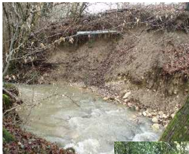
Le Groise avant travaux
