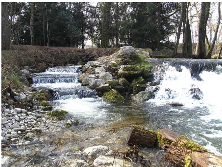
Passé à poissons sur l'Allemogne
