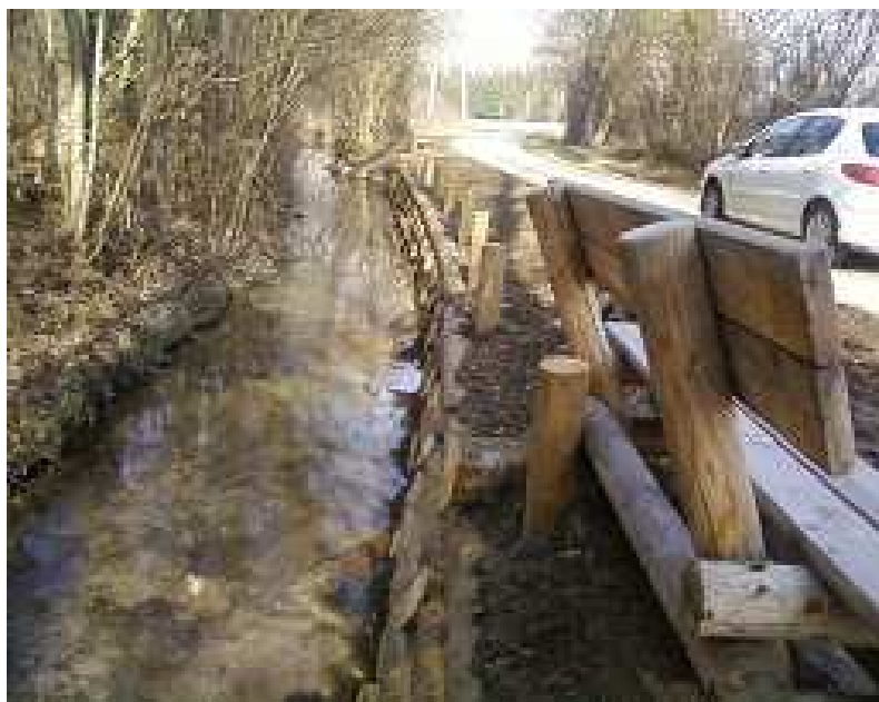
Le bief du Lion après travaux
