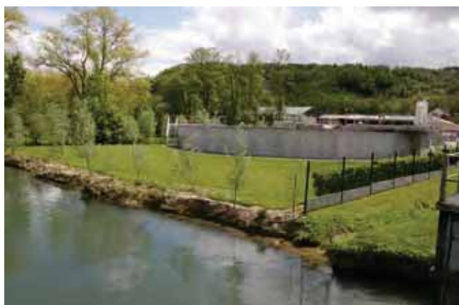
Photo 8 : La station d'épuration de Wizernes.
