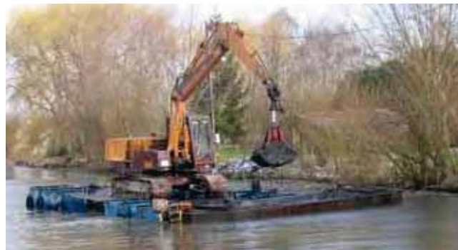
Photo 18 : Travaux de curage réalisé par la 7ème section des Wateringues.
