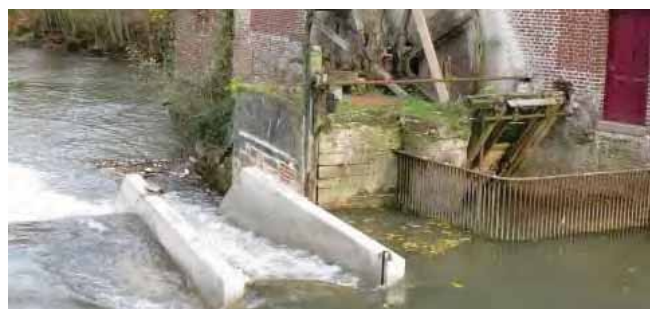
Photo 11 : Le moulin Snick dont le seuil a été équipé d'une passe à poissons.
