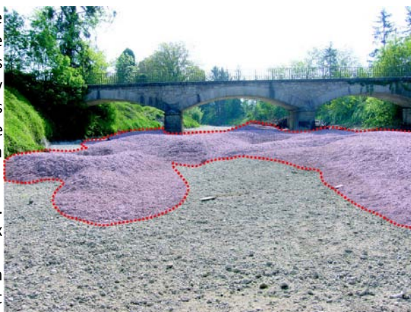
Figure 17: Accumulation de charge solide (d'un hiver) en aval du pont de la VC6 à Saint-Maurice de Rémens dans l'Albarine asséchée
