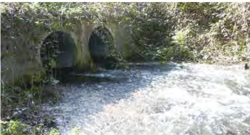
Combinaison de facteurs : tirant d'eau insuffisant, radier béton en aval et vitesse d'écoulement trop élevée
