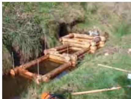
Buse aménagée par bassins en bois (mélèze) pré-construits en hangar puis démontés et remontés sur site
