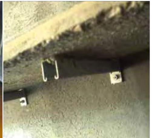
Les équerres risquent de coincer des branchages à l'intérieur de l'ouvrage.
