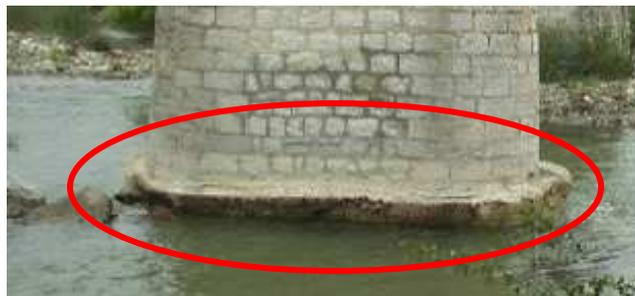
**Figure 2-23 – déchaussement de pont à Lanas – Auzon**
