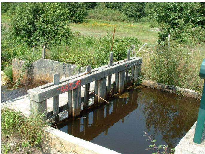
*Ouvrage de régulation du niveau d'eau du moulin de la Mole*
