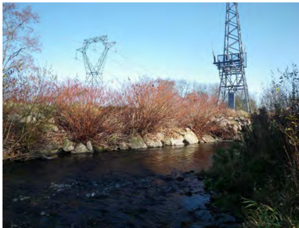
Photo 32 : enrochements importants en rive gauche en amont du tronçon Gie9.
