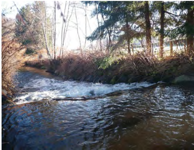
Photo 48 : un des seuils rencontrés entre Sainte-Croix-aux-Mines et Lièpvre. Ce type de seuil a été mis en place pour maintenir une certaine ligne d'eau et empêcher que le lit ne s'incise d'avantage.
