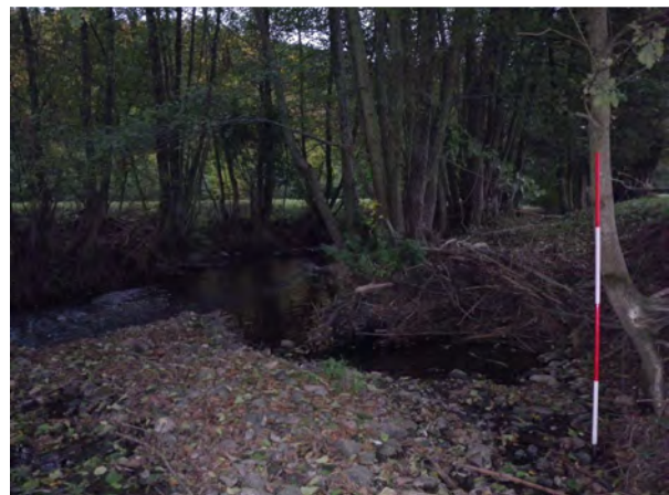
Photo 25 : encoche d'érosion à l'aval de l'ouvrage du Volgenloch. La reprise de l'activité érosive de la rivière peut être conséquence du blocage du transit sédimentaire par le barrage à l'amont.
