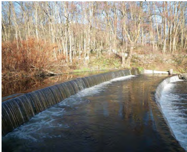
Photo 30 : un exemple de seuil sur le tronçon Gie8. Ce dernier, d'une hauteur de chute importante n'est actuellement pas franchissable pas le sédiment.
