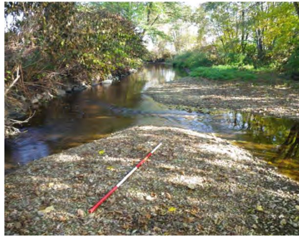
Photo 41 : le Giessen dans sa partie aval : la quasi-totalité du linéaire du dernier tronçon du Giessen présente ce type de configuration : berges enrochées, courbures peu marquées, dépôts d'éléments fins en intérieur de courbes, affouillement sous les enrochements en place...
