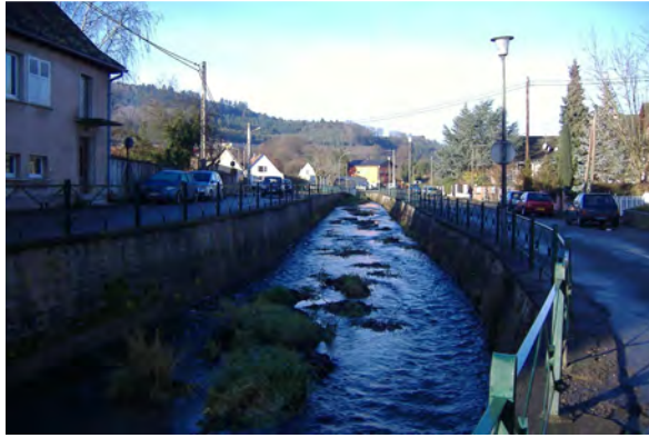
Photo 8 : atterrissement dans Villé : ce type de dépôt en amont d'un pont peut poser le problème de diminution de la capacité du lit mineur (fonctionnalité du lit majeur fortement dégradée dans la traversée de la ville), accroissant ainsi le risque d'inondation.
