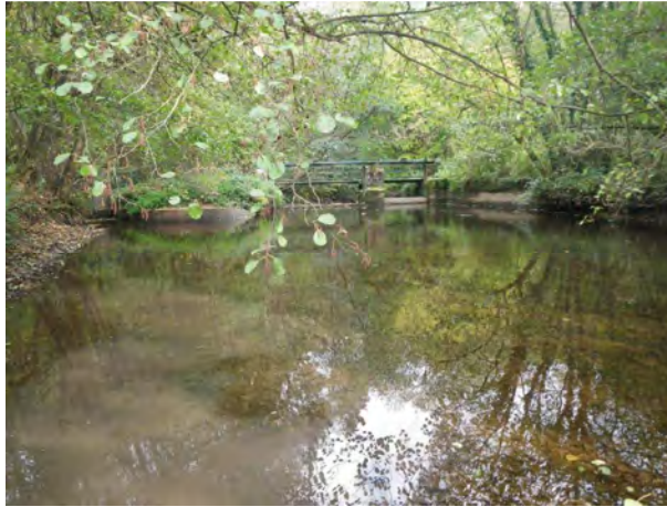
Photo 28 : l'amont de l'ouvrage de la prise d'eau de l'Aubach. On observe un léger colmatage des fonds par de la vase dans la zone de remous de cette ouvrage infranchissable tant pour le poisson que pour le sédiment.
