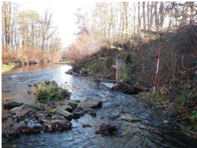
Photo 34 : un enrochement détruit par la puissance de la rivière.
