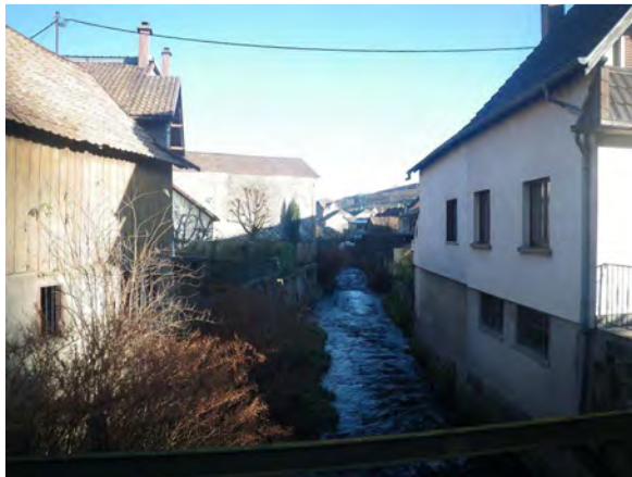
Photo 46 : la Lièpvrette dans la traversée de Sainte-Croix-aux-Mines.
