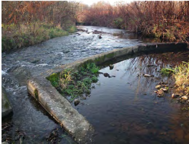
Photo 57 : un élément transversal en béton qui permet de visualiser le transport solide.
