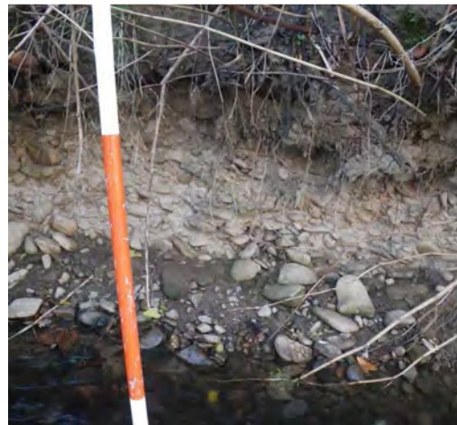
Photo 35 : nature des berges sur le cône de déjection du Giessen. Ces éléments de taille centimétrique à pluri-centimétrique permettent une porosité inter granulaire importante, responsable des relations nappe alluviale/rievière (notamment infiltration des eaux du Giessen en période de basses eaux).
