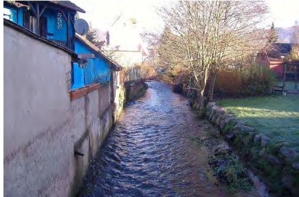
Photo 9 : équipements rencontrés sur Villé : ce type d'aménagement (murs et enrochements) ne permet pas une diversification des habitats (peu de formes sédimentaires) ainsi que des faciès d'écoulement. Ce tronçon est majoritairement une zone de transport de sédiments.
