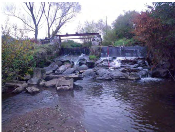
Photo 24 : le barrage de prise d'eau du moulin de Volgenloch (qui possède encore une activité hydroélectrique). Ce seuil est infranchissable par les sédiments ainsi par les poissons.
