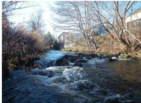
Photo 47 : la Lièpvrette à hauteur de la scierie de Sainte-Croix-aux-Mines. Le seuil visible au premier plan, ainsi que les autres en arrière plan sont franchissables par les sédiments du fait des conditions locales d'écoulements (rivière torrentielle).
