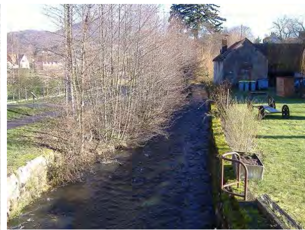
Photo 15 : le Giessen d'Urbeis à son entrée dans Villé. La qualité physique globale de la rivière diminue du fait des aménagements de berges.
