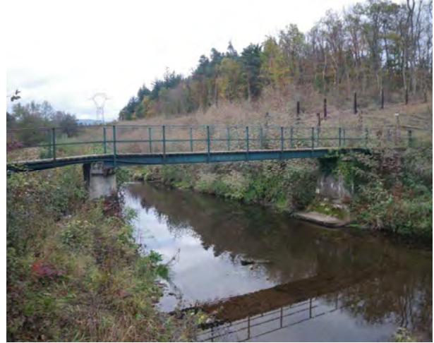
Photo 27 : la zone centrale du tronçon Gie6 : Cette zone rectifiée sous laquelle passe une ligne haute tension EDF (végétation arbustive entretenue) diminue la qualité globale du tronçon.
