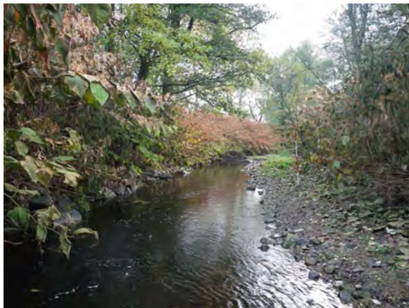
Photo 53 : la Lièpvrette à l'aval de Lièpvre. La présence de l'enrochement en rive gauche conduit à un affouillement sous ce dernier. En rive droite, des dépôts d'éléments relativement fins sont observables.
