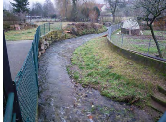
Photo 4 : présentation des types de contraintes latérales à Maisonsgoutte (rive gauche emmurée, rive droite bétonnée). En amont, des berges déstabilisées ont été constatées.
