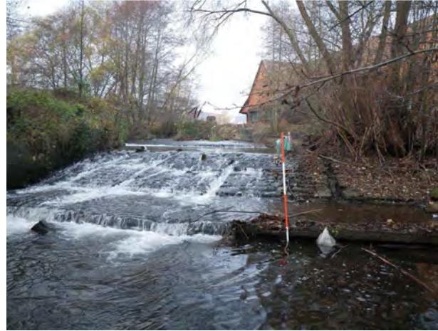
Photo 17 : le seuil SENGLER à Villé . Cet ouvrage, d'une hauteur de chute de 1,50 m environ est franchissable par le sédiment mais semble difficilement franchissable par les poissons comme la truite fario, espèce migratrice de référence sur le Giessen.
