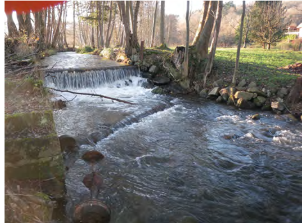
Photo 13 : détail d'un seuil en amont de Bassemberg : dans le contexte dans lequel se trouve le Giessen d'Urbeis à cet endroit (rivière torrentiel), un seuil d'importance comme celui-ci (hauteur de chute d'environ 60 cm) n'a dans ce contexte qu'un impact modéré sur le transport solide.
