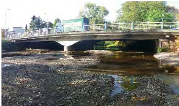
Photo 36 : sous dimensionnement du pont de la N83, qui, associé à une rupture de pente probable, engendre un important atterrissement à l'aval de celui-ci (dépôt de plusieurs centaines de m 3 par an de matériaux grossiers).
