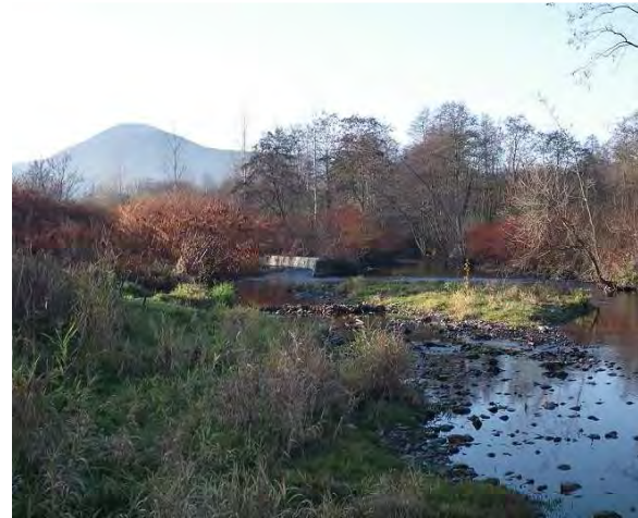
Photo 58 : la confluence du Giessen et de la Lièpvrette. Un mur a été construit afin de limiter l'érosion des berges par la Lièpvrette (La Lièpvrette est située à gauche sur la photo).
