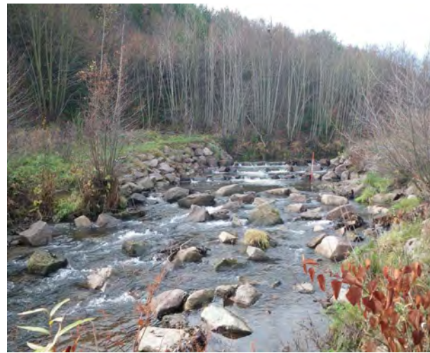
Photo 21 : un des seuils réaménagés sur la propriété de la CC de Villé pour la continuité écologique. De larges échancrures entre les blocs de pierres permettent la franchissabilité de l'ouvrage par le poisson ainsi que par les sédiments.
