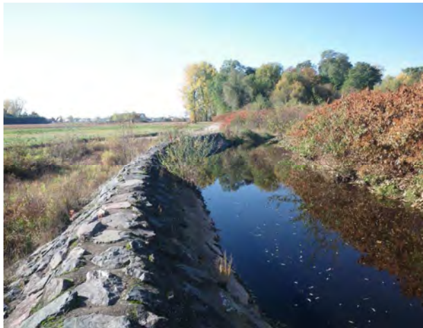
Photo 38 : déversoir de crue permettant la protection contre les inondations d'Ebersheim (cf. résultats enquête).
