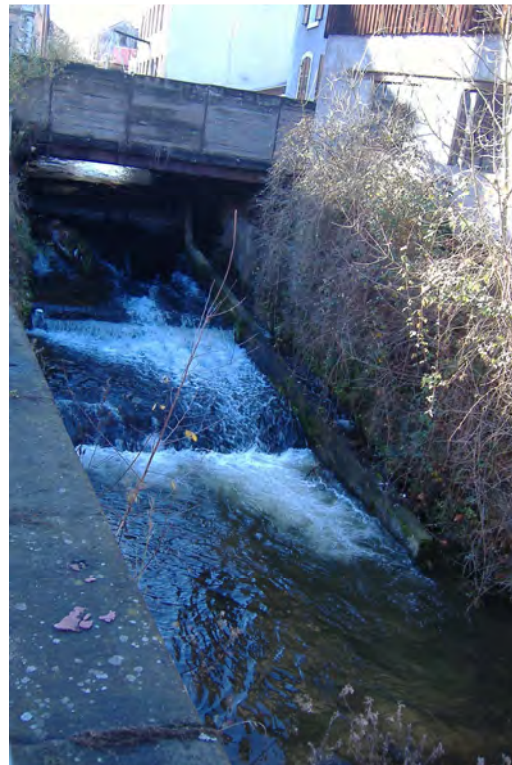
Photo 43 : ouvrage réaménagé pour la continuité piscicole.
