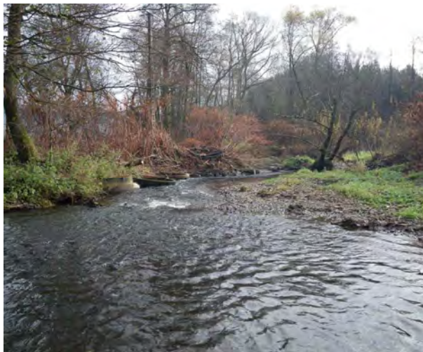
Photo 20 : le Giessen à l'aval de Saint-Maurice : La rivière sur ce tronçon possède un potentiel de mobilité important, mais est fortement rectifiée par endroit. Les protections de berges en béton (rive gauche sur la photo) vont être supprimées (projet CC de Villé).
