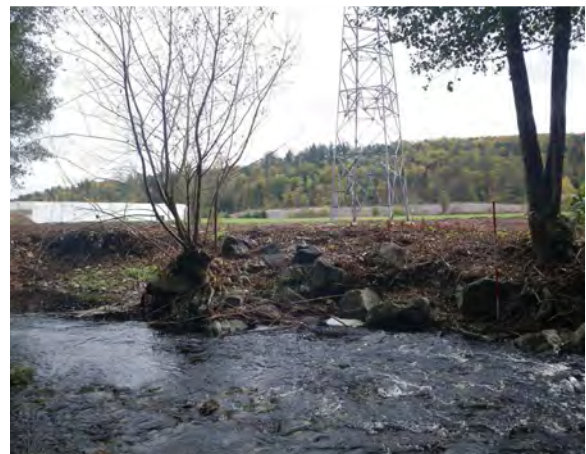
Photo 55 : enrochements en rive droite de la Lièpvrette. Les berges de ce tronçon sont fortement artificialisées, des enrochements en rive droite essentiellement protègent des infrastructures situées à proximité immédiate du lit mineur (pylône électrique en second plan et usine en arrière plan).
