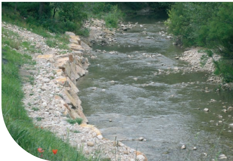
La Nartuby - Aménagement des berges (83)
